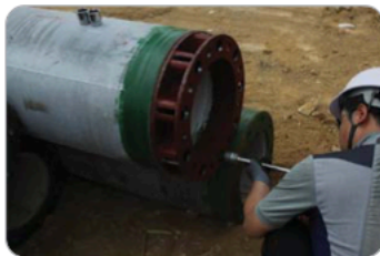
② 임팩렌치를 사용한 Joint 체결
