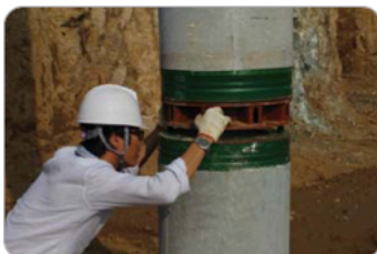
④ 하부파일에 Joint결합된 상부파일 거치
