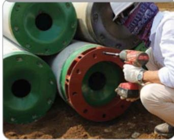
아적된 상태에 Joint 부착
